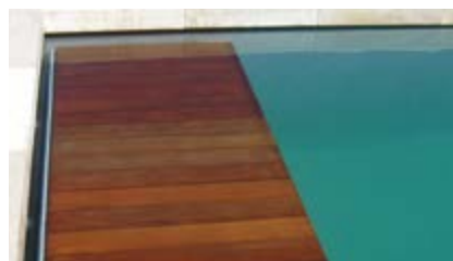
Volet immergé rangé dans son caisson
